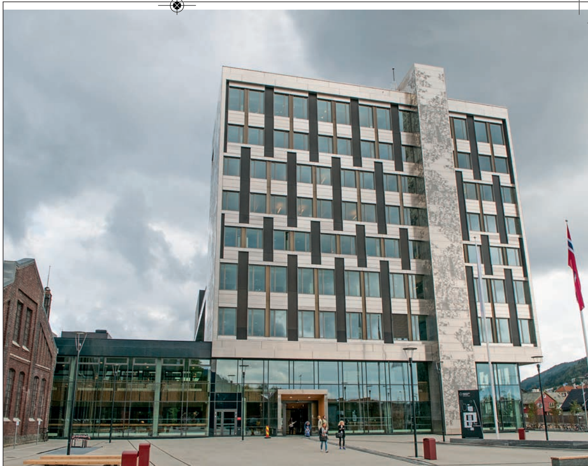
På Kronstad har Høgskolen i Bergen tatt i bruk nye lokaler på 51.000 kvadratmeter og samlokalisert lærer-, sykepleie- og ingeniørutdanning.
